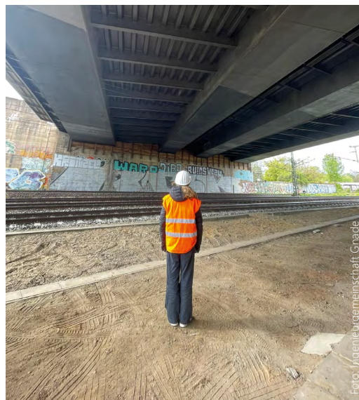
Auf der Baustelle: Sophie vom Professor-Friedrich-Förster-Gymnasium in Haldensleben (7. Klasse)
